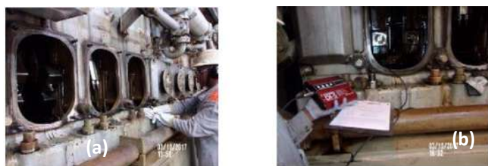
Figura 3 - (a) Remoção das tampas do cárter (b) Leitura da deflexão.
