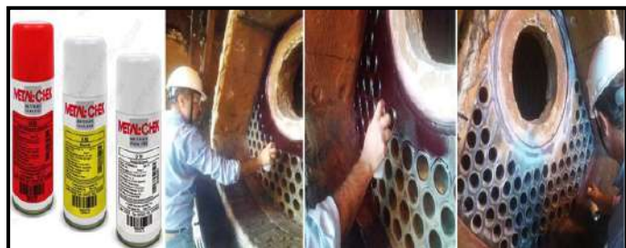
Figura 10: Aplicação de líquido penetrante (END). Fonte: Autores, (2019).
