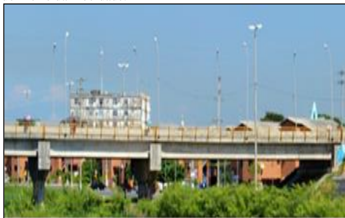
Figura :Igarapé do quarenta a ponte do bairro morro da liberdade. Fonte: Autores, (2018).
