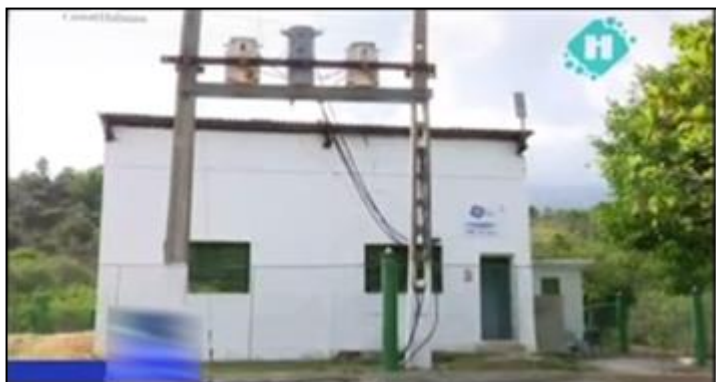
Figura 10: Caseta de la mini hidroeléctrica El Dian (Ocujal del Turquino).
