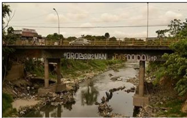
Figura 7 :Igarapé do quarenta na ponte do bairro raiz. Fonte: Autores, (2018).
