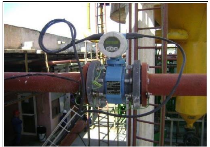
Figura 12: Flujómetro Promag 10P2F a la entrada de los tanques de agua cruda. Fuente: Los Autores, (2015).
