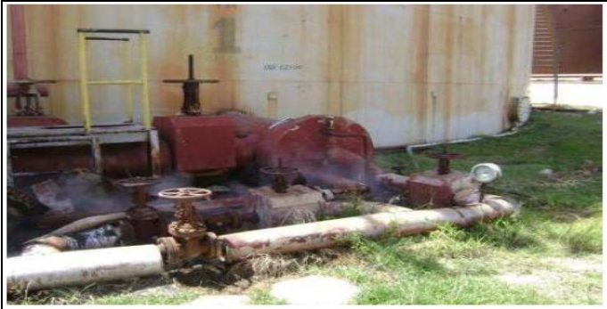
Figura 7: Calentador de Boca de uno de los tanques de almacenamiento de combustible.
