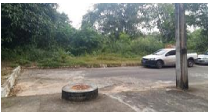
Figura 3: Vista do local de instalação com caixa de passagem.
