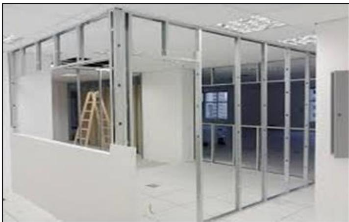
Figura 3: Instalação Drywall.
