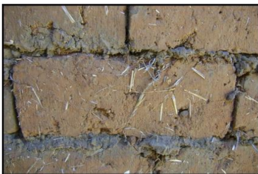
Figura 1: Tijolo confeccionado com fibras vegetais e argila, usado na construção de casas.
