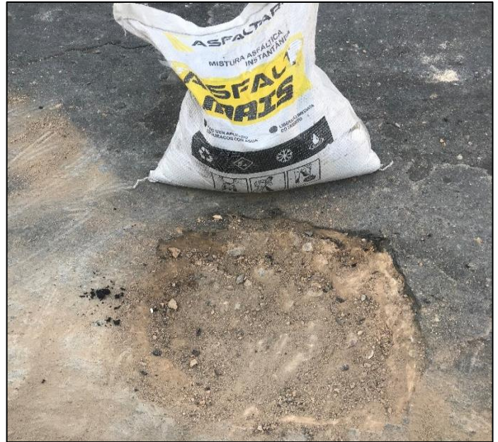
Figura 6: limpeza do material Solto Fonte: Autores, (2018).
