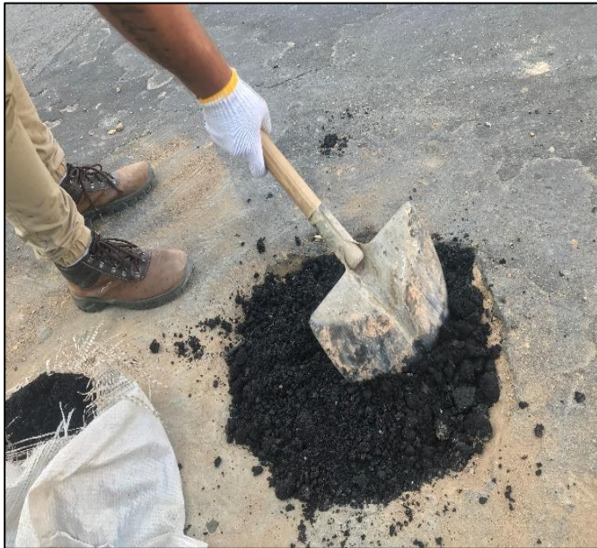
Figura 8: Espalhar a massa asfáltica uniformemente Fonte: a Autora, (2018).
