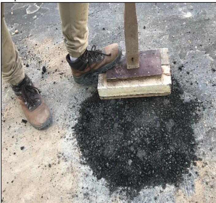
Figura 9: Realização da Compactação Fonte: a Autora, (2018).
