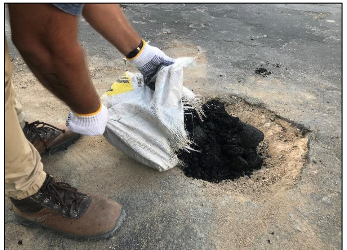
Figura 7: Aplicação da massa Asfáltica Fonte: Autores, (2018).
