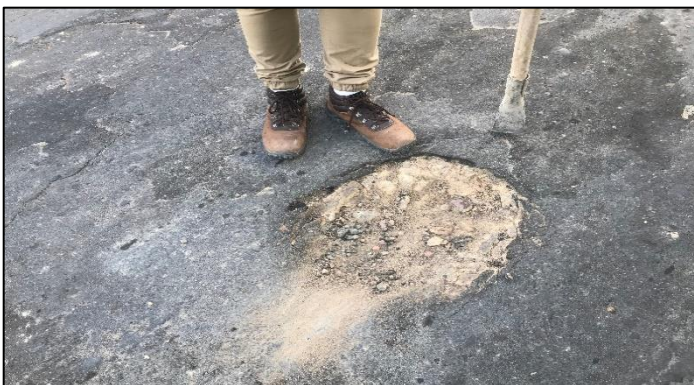
Figura 5: Realização de cortes nas bordas do buraco no local identificado Fonte: Autores, (2018).
