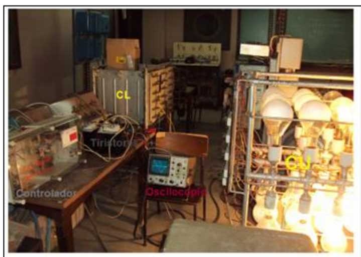
Figura 7: Prototipo de pruebas experimentales para control local de la mini-hidroeléctrica
