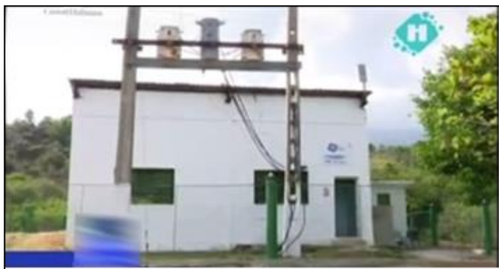
Figura 10: Caseta de la mini hidroeléctrica El Dian (Ocujal del Turquino).
