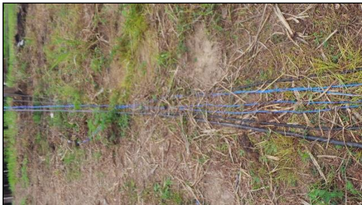
Figura 14: Cabeção elétrica lançada no solo.
