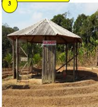
Fig. 7. Construção do Galinheiro Fonte: [14].
